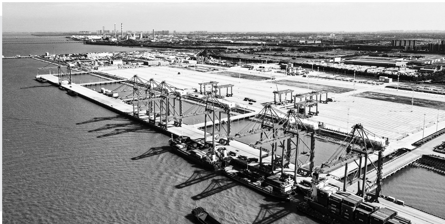
俯瞰太仓港集装箱四期码头。中交三航局供图
