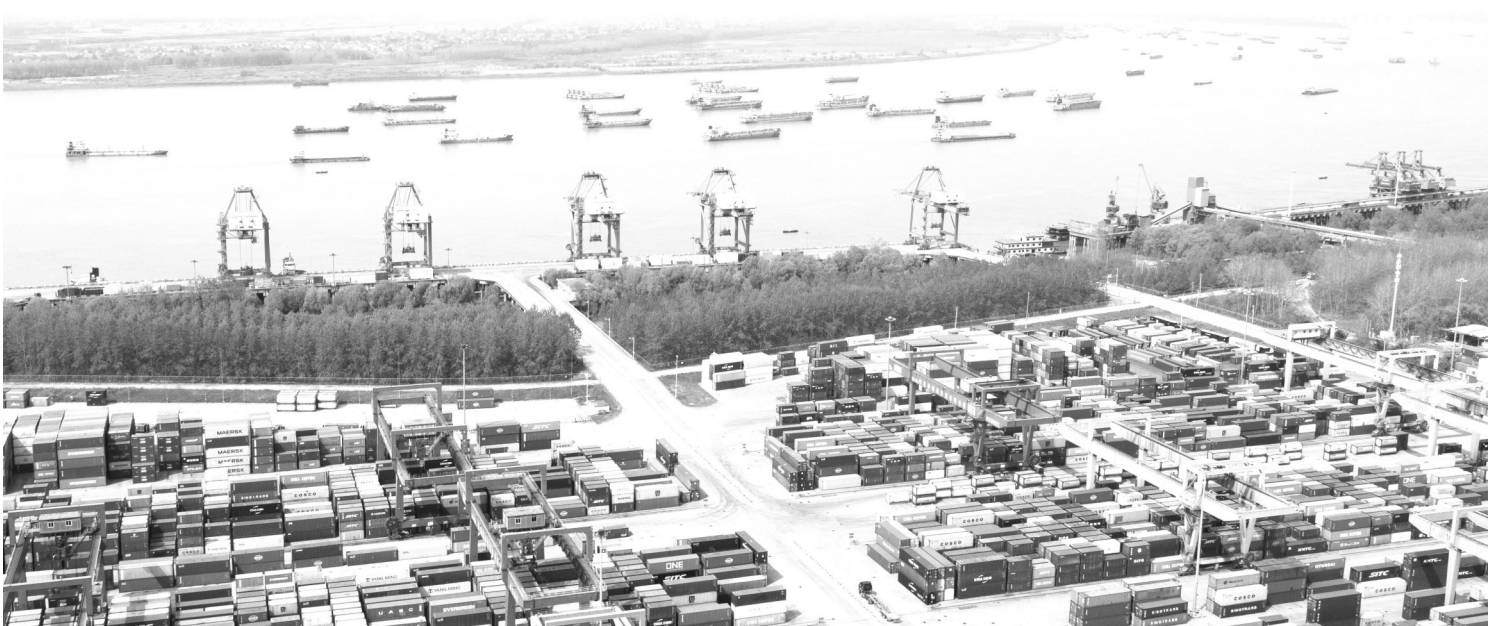
俯瞰阳逻港。本报资料室供图
