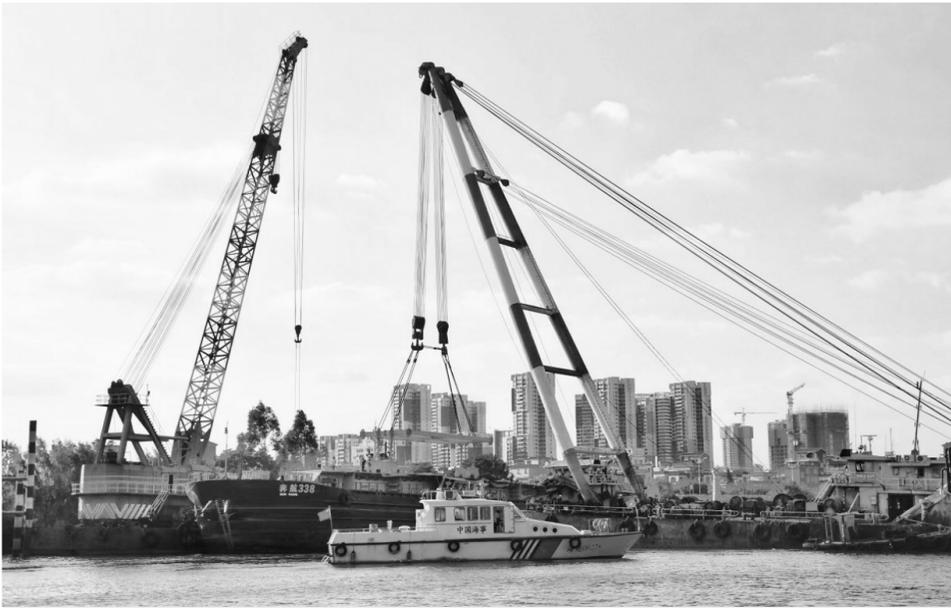
10月11日,佛山凤翔大桥钢箱梁开始吊装施工,佛山海事局安排执法力量对施工水域实施交通管制,确保施工顺利进行和施工水域水上交通安全。龙巍 张植凡/文 韩星辉/图
