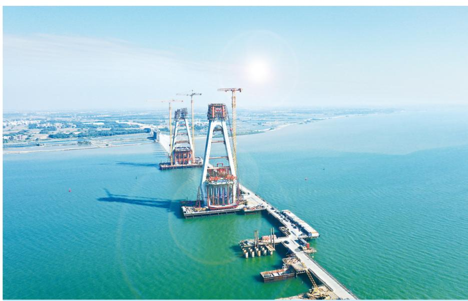
11月16日,南三岛大桥主桥南主塔封顶。南三岛大桥主桥为双塔双索面斜拉桥,全长562米,横跨海运通道,主跨300米,可满足3000吨级海轮通航。项目建成后,岛上居民出岛时间将节省30分钟。 龙巍 张植凡/文 粤交集宣 张立希/图
