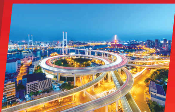
《国家综合立体交通网规划纲要》提出：建设综合交通枢纽集群、枢纽城市及枢纽港站“三位一体”的国家综合交通枢纽系统。图为上海城市立交桥。
