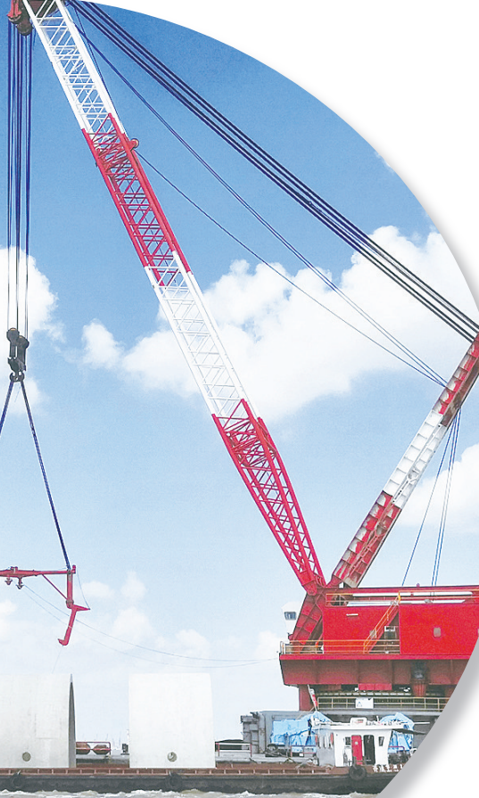
航道整治建筑物半圆体安装。
