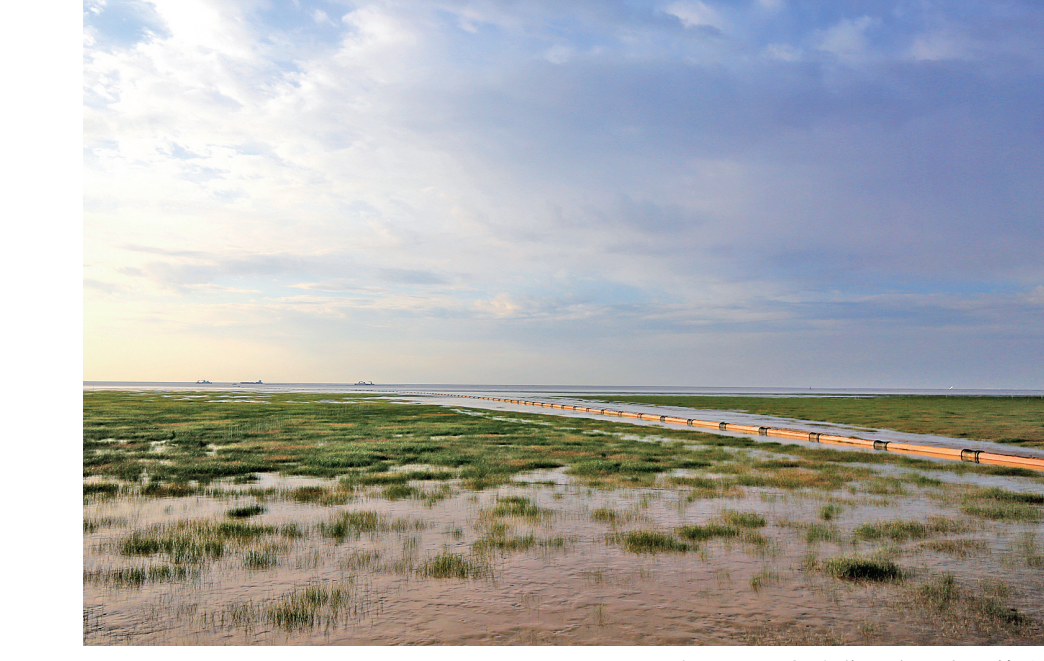
长江口深水航道疏浚土吹泥管线。
