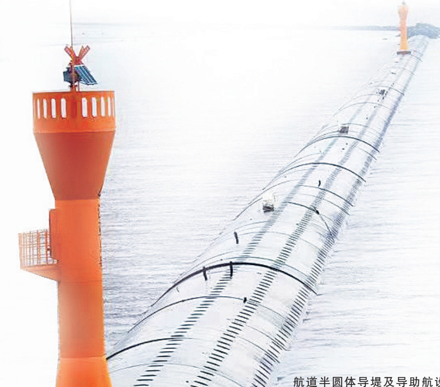
航道半圆体导堤及导航助航设施。本版图片由长江口航道管理局提供
