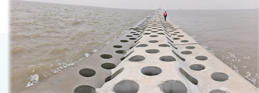
实施长江口深水航道减淤工程南坝田挡沙堤加高工程，减淤效果明显。
