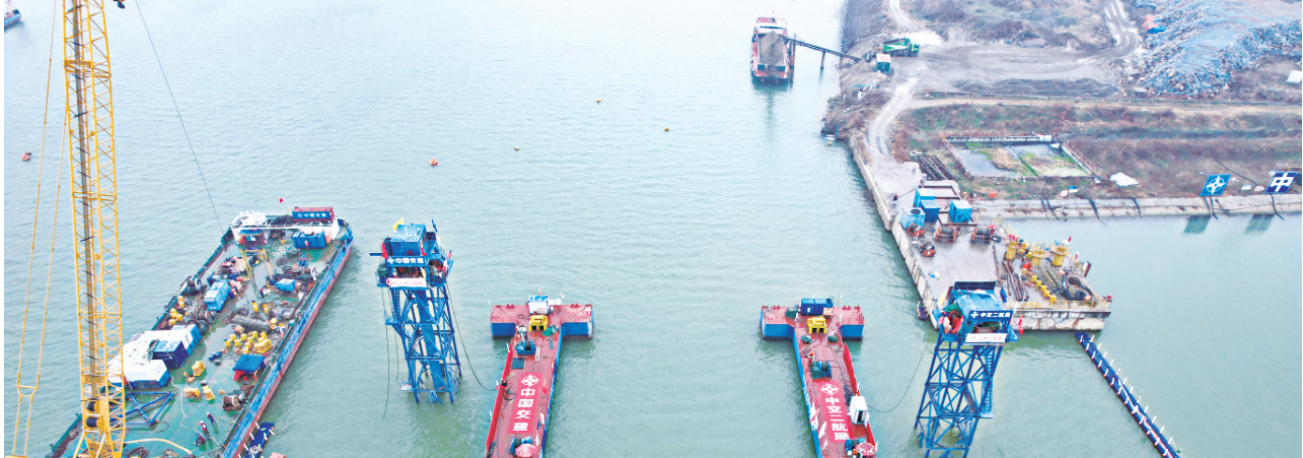
2 月 17 日,由中交二航局参与投资建设的襄阳市东西轴线(襄江大道)鱼梁洲过江隧道完成最后一节沉管安装。至此,10 节沉管全部安装到位,建设团队向着下半年全线贯通的目标冲刺。 据了解,襄阳市东西轴线(襄江大道)鱼梁洲过江隧道全长 5.4 公里,是国内整体规模最大的内河沉管隧道、华中地区首条内河沉管隧道。 许豹 摄
