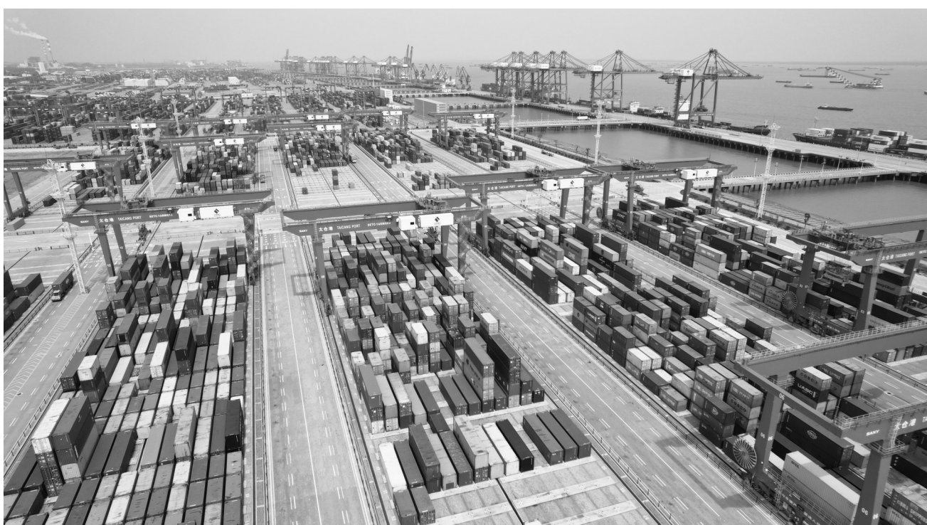
6月21日至22日,中交三航局承建的苏州港太仓港区四期项目水工标段和陆域标段竣工验收。据了解,该项目为长江流域首个自动化堆场码头,于2021年6月28日正式开工建设,截至今年5月31日,太仓港四期项目累计船舶作业达7901艘次,完成箱量88.14万标箱。目前该码头以中转业务为主,从长江上游以及安吉方向中转到外高桥及洋山方向。 马飞宇 摄
