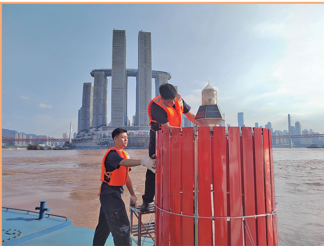
山城重庆气温一路“飙升”,已达到40℃,江面上更是开启“上蒸下煮”模式。重庆江洲航道处职工在早晚时间,对浮标锈蚀的钢缆、标体的幌丝进行检查更换,为洪水的到来做好准备。 唐浩然 摄
