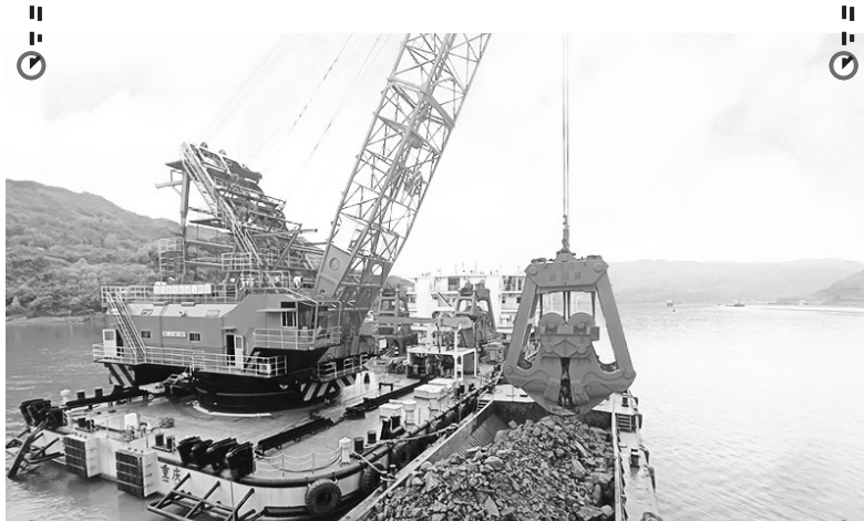
▲抓斗挖泥船“长鹰9”。长江重庆航道工程局供图
