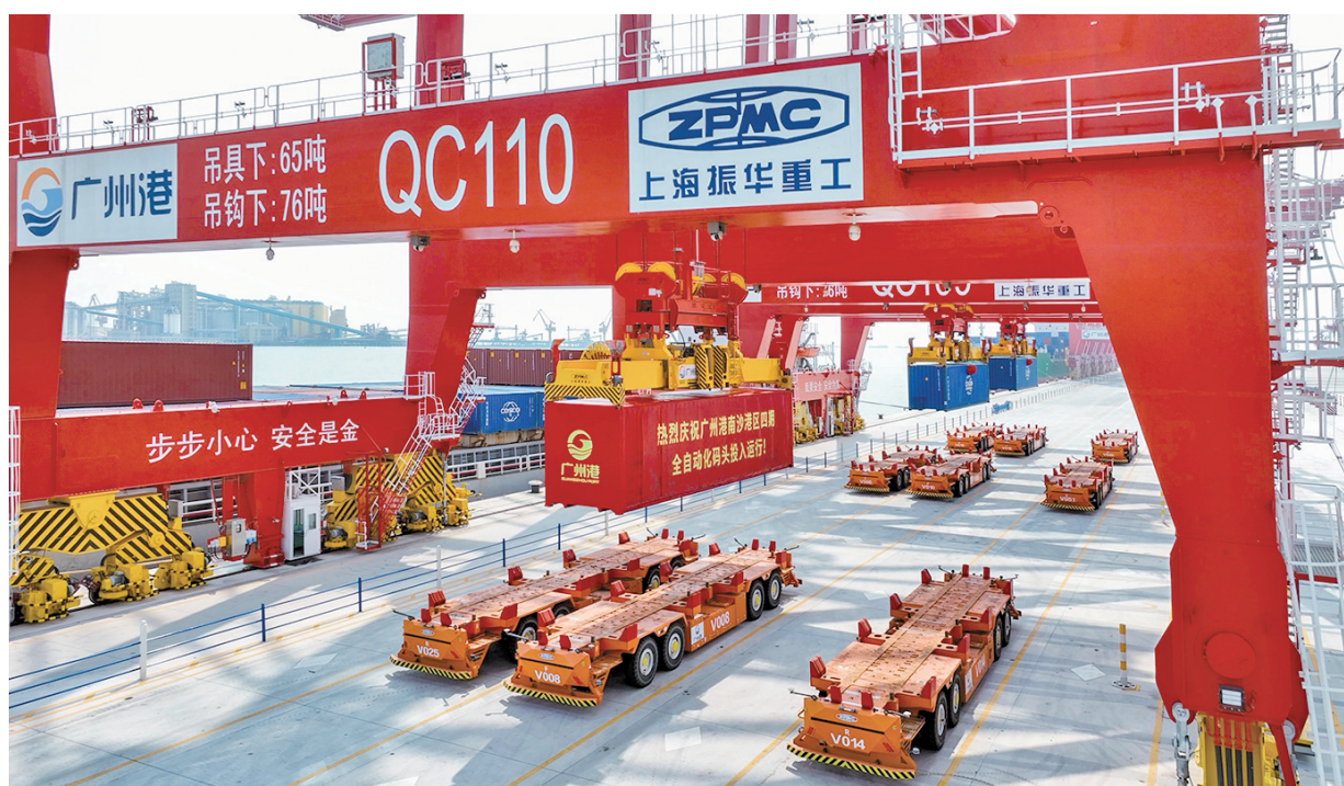
7月28日,振华重工系统承包的广州港南沙港区四期全自动化码头正式投入运行。该码头是全球首个江海铁多式联运全自动化码头,也是粤港澳大湾区首个全新建造的自动化码头。南沙四期全自动化码头是我国首例由国内科技力量联手打造的全自动化集装箱码头,建有4个10万吨级海轮泊位及配套集装箱驳船泊位。集北斗导航、5G通讯、人工智能、无人驾驶等前沿技术于一体,从自动化设备硬件到信息化系统采用全新一代自动化集装箱码头技术路线,创造了60多项专利,其中发明专利31项。 龙巍 张植凡/文 朱俊坤/图
