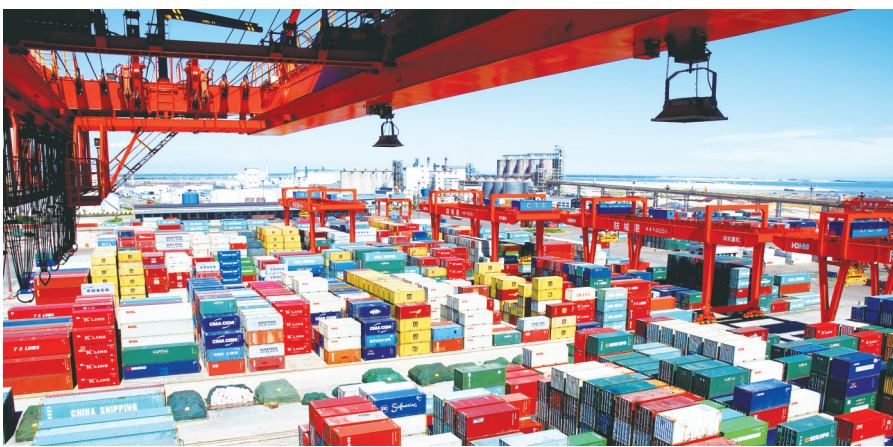
防城港集装箱堆场。
