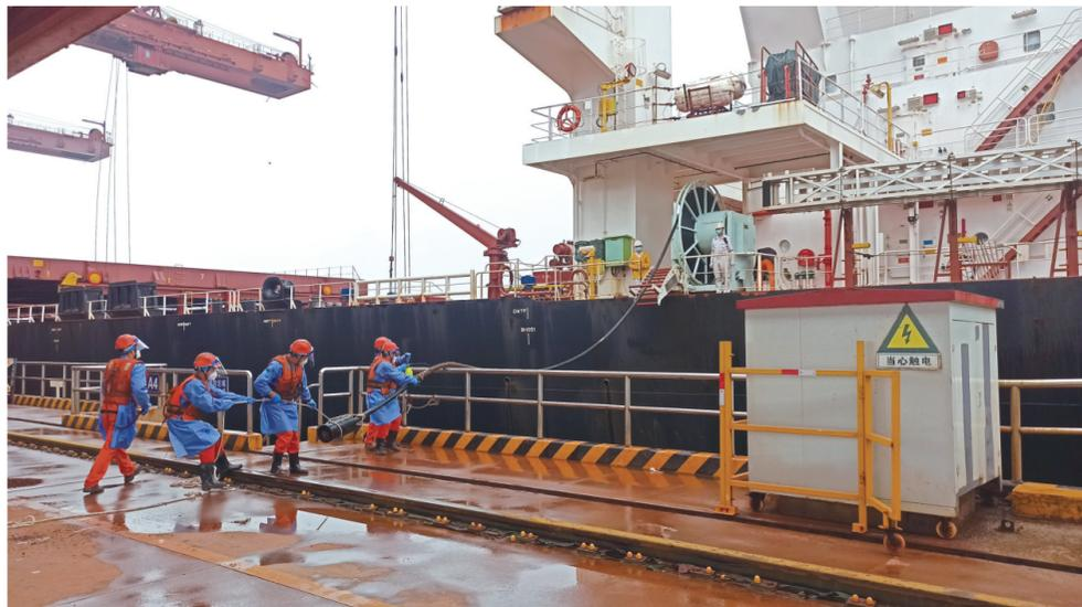
近日,靠泊山东港口青岛港的40万吨级货轮“明青”轮成功接通码头岸电,实现合闸并网运行。据统计,一艘40万吨级货轮在港停靠期间使用岸电,可以减少燃油消耗量约12吨,可减少二氧化碳排放量约37.4吨,减少硫氧化物排放约0.1吨。
