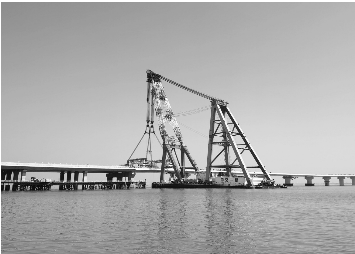
厦门翔安大桥合龙现场。蔡修权 摄
