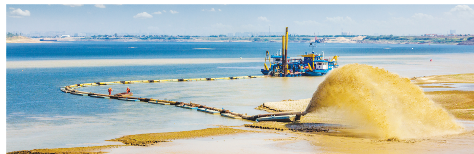
疏浚整治航道。
