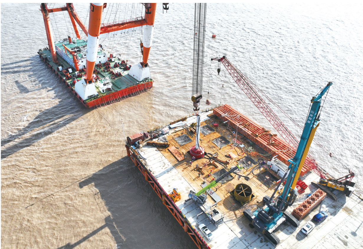
▲近日，福州港罗源湾港区可门作业区6#、7#泊位工程首根钢管桩沉桩顺利完成，标志着该项目码头主体工程进入关键阶段。 王有哲 陈勤思 摄
