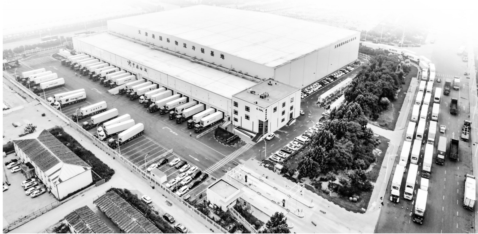
天津港国际物流冷链基地。
