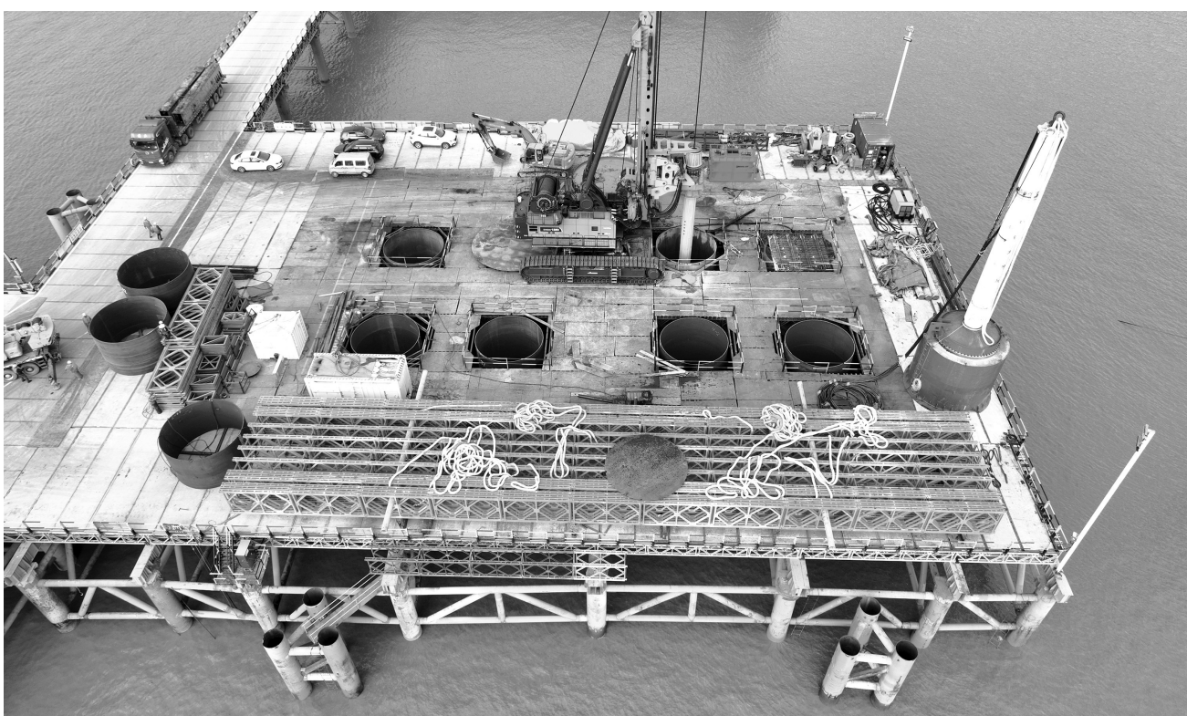
2月18日，浙江省舟山市定海区册子岛海边，世界最大跨度公铁两用大桥和世界最宽跨海大桥——甬舟铁路西堠门公铁两用大桥首桩开钻。西堠门公铁两用大桥是甬舟铁路及甬舟高速公路复线跨越西堠门水道的共用跨海桥梁，连接舟山金塘岛和册子岛。大桥全长3118米，主跨采用1488米斜拉悬索协作体系，桥面宽68米，是在建的世界最大跨度公铁合建桥梁和世界最宽跨海大桥。姚峰 摄
