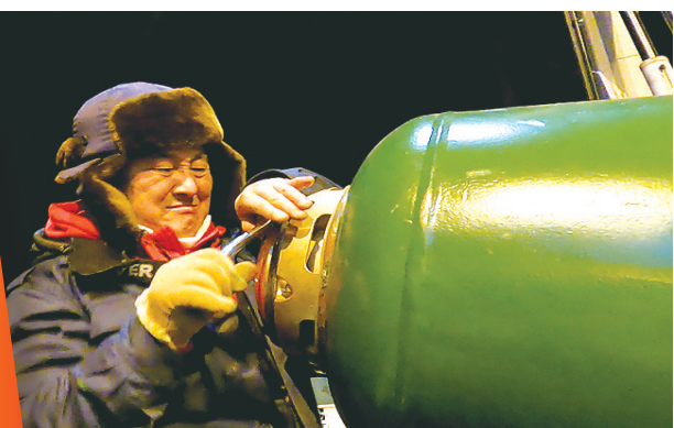
▲北海航海保障中心大连航标处大港航标管理站栾晓辉顶着严寒安装灯器,为船舶提供夜间导航服务。 马建满 摄
