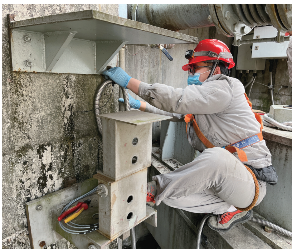
▲三峡船闸南线计划性通航检修现场,船闸青年技术人员在人字门与闸墙的间隙边作业。 宋莉 摄
