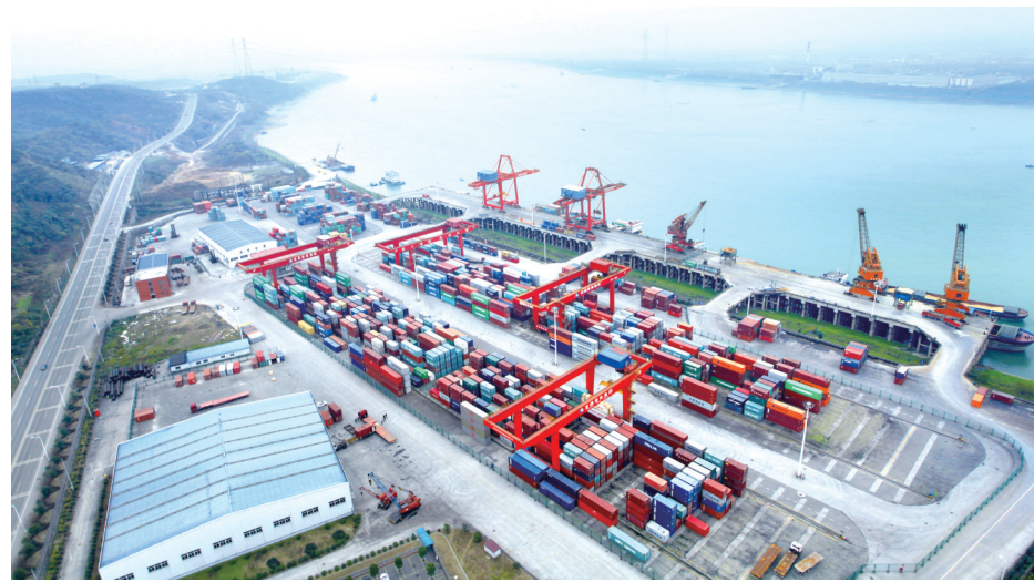
宜昌港主城港区云池作业区码头工程。
