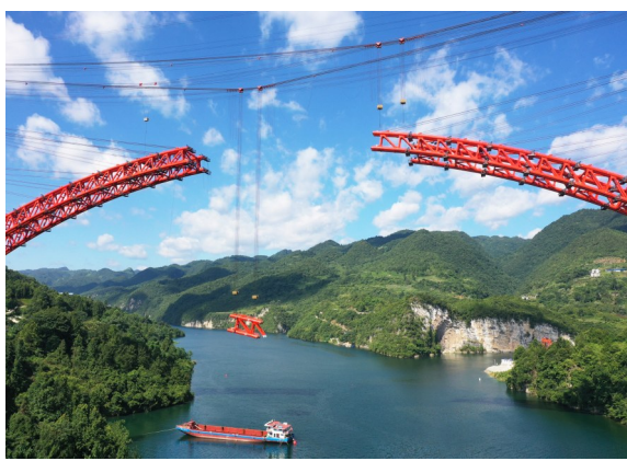
乌江复航“运来”一座世界级大桥——万吨级钢拱梁通过水运从长江运达德余高速公路乌江大桥建设工地，并进行水上吊装。
