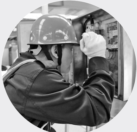
选手使用万用表确认市电接入断开。
