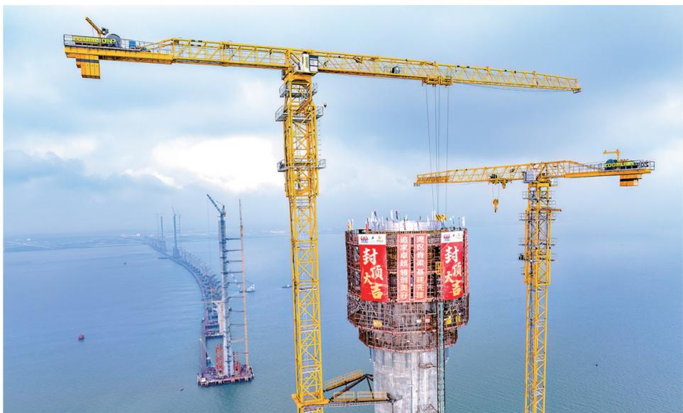
4月18日上午，黄茅海跨海通道项目最后一座主塔——黄茅海大桥中塔顺利封顶(如图)。至此，项目的关键工程黄茅海大桥和高栏港大桥五座主塔全部封顶，项目建设即将进入斜拉索和钢箱梁架设新阶段。黄茅海大桥主跨径2×720米，全长2200米，为世界上跨径最大的三塔公路斜拉桥。此次封顶的中塔高约263.78米，相当于80多层楼高。
