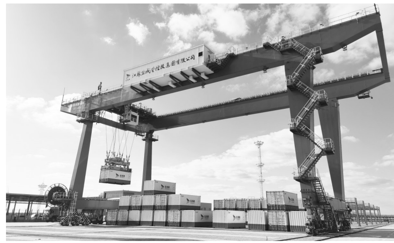
盐城港集团集装箱港区。
