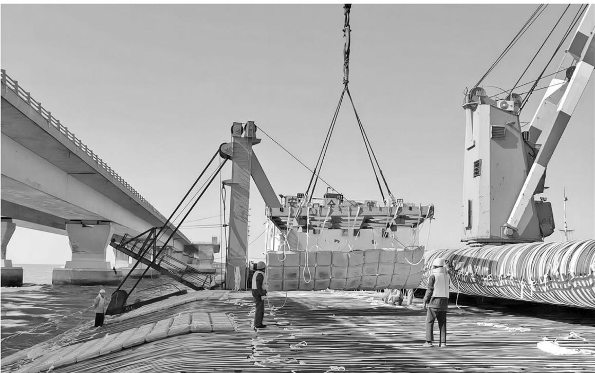
5月23日,伴随着滚筒的转动,最后一排联锁片缓缓从长专3号铺排船的甲板上,精准滑落到东海大桥PM440桥墩区域。至此,由中交三航局承建的东海大桥桥墩过冲区区域防护工程深水软体排铺设,完成所有施工
