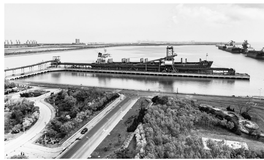
国能黄骅港务公司泊位正在进行煤炭装船作业。
