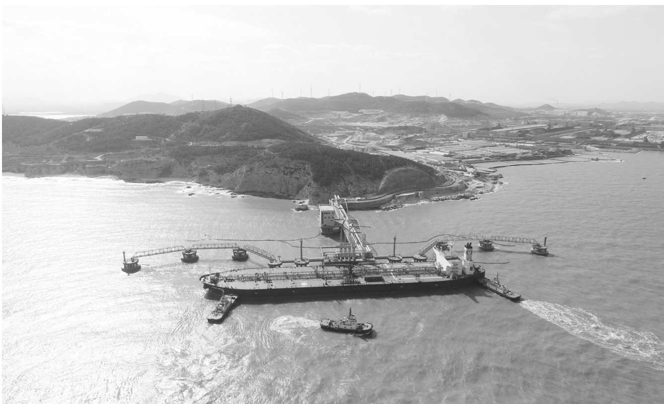
山东港口烟台原油码头。 本报资料室供图
