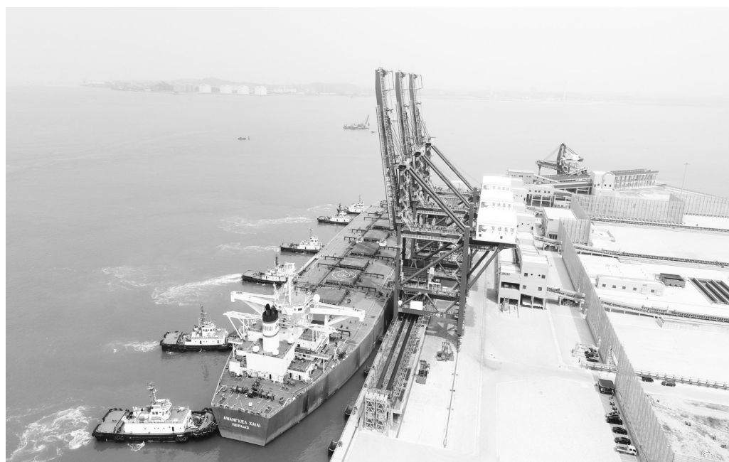
湄洲湾东吴港区罗屿作业区。本报资料室供图
