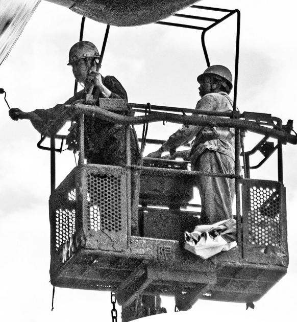
广东中远海运重工供图 工人进行喷漆作业。
