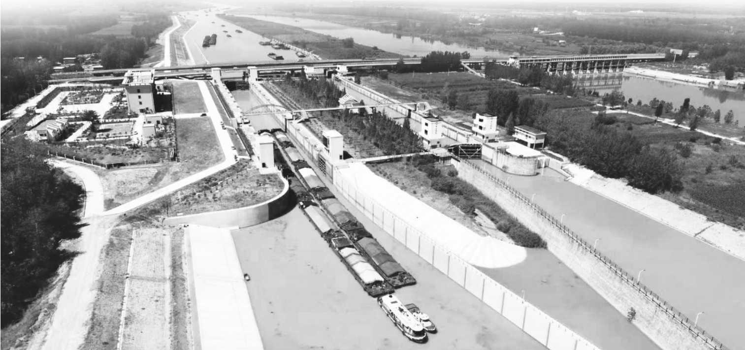
京杭大运河济宁段微山二线船闸。 张伟 摄
