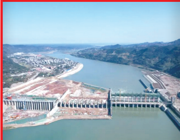
引江济淮航运工程。
