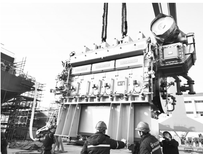
武昌造船建造的 13000DWT 甲板运输船 12 号船进行主机吊装。 梅竹新 摄
