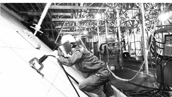
上海外高桥造船技术人员进行焊接作业。 李茂君 摄
