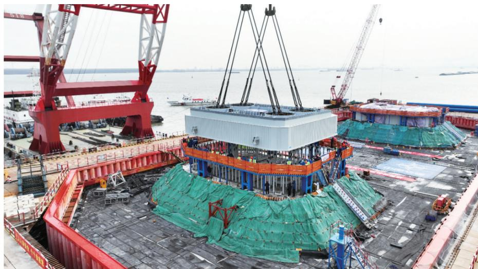
3月1日,世界最大跨度悬索桥——张靖皋长江大桥建设取得重要进展,南航道桥南主塔上下游塔塔柱实现第一节段精准安装,安装误差控制在2毫米内,标志着南主塔进入“拔节长高”新阶段。
