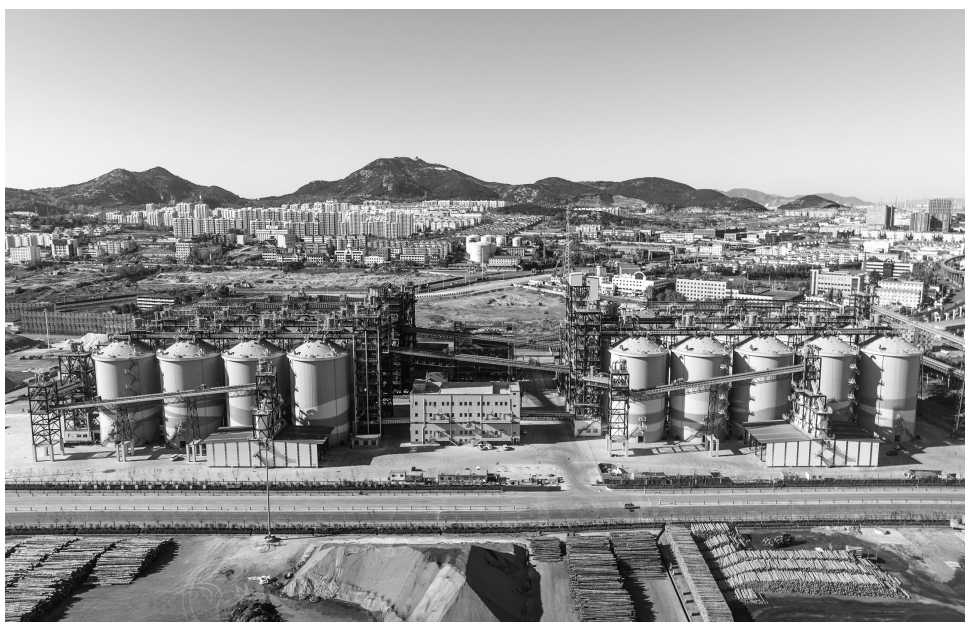
日照港岚山港区南作业区散粮改扩建工程。 王刚 摄
