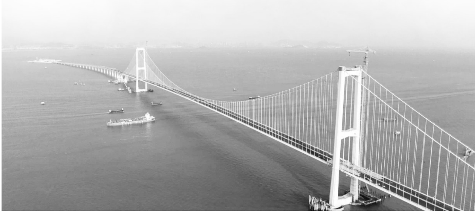
深中通道伶仃洋大桥。本报资料室供图
