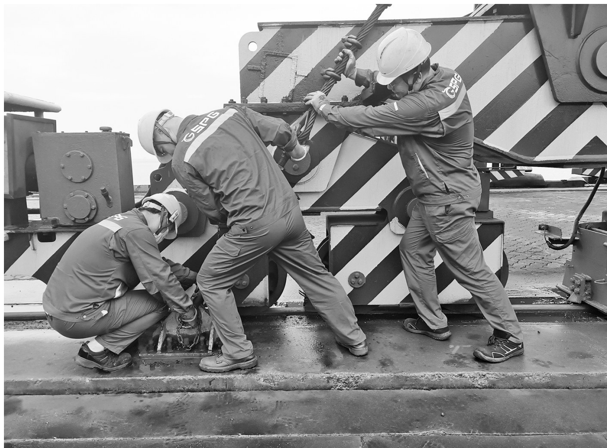
连日来，山东港口日照港一公司结合生产实际，根据夏季气候特点制定防范措施，扎实做好夏季“四防”工作。 图为工作人员全面排查现场机械防风设施。 马榕蔚/文 高广建/图
