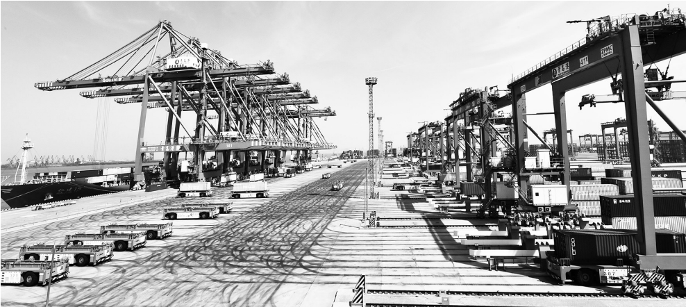
青岛港全自动化码头作业现场。 本报资料室供图
