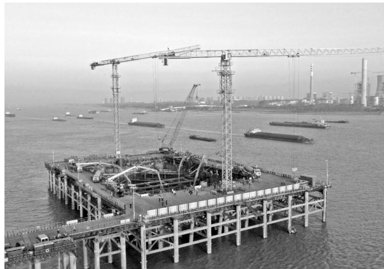
10月26日,由中交二航局施工的安徽池州长江公铁大桥北主塔主墩承台浇筑全部结束,将进入主塔塔身施工阶段。此次浇筑的北主塔主墩为3号主墩,采用双壁钢套箱围堰施工工艺。承台平
