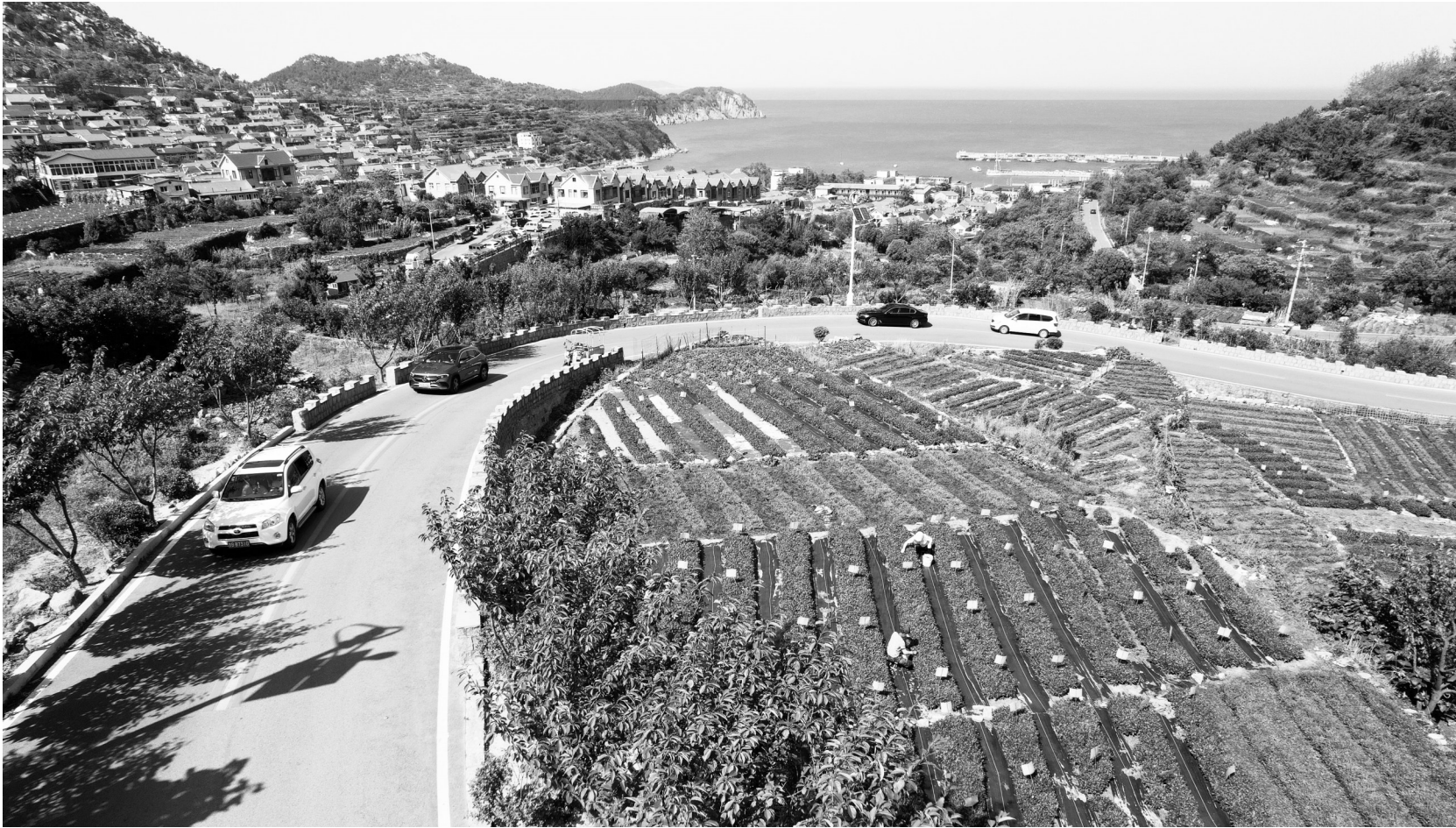
崂山区的青山进村路。 青岛市交通运输局供图
