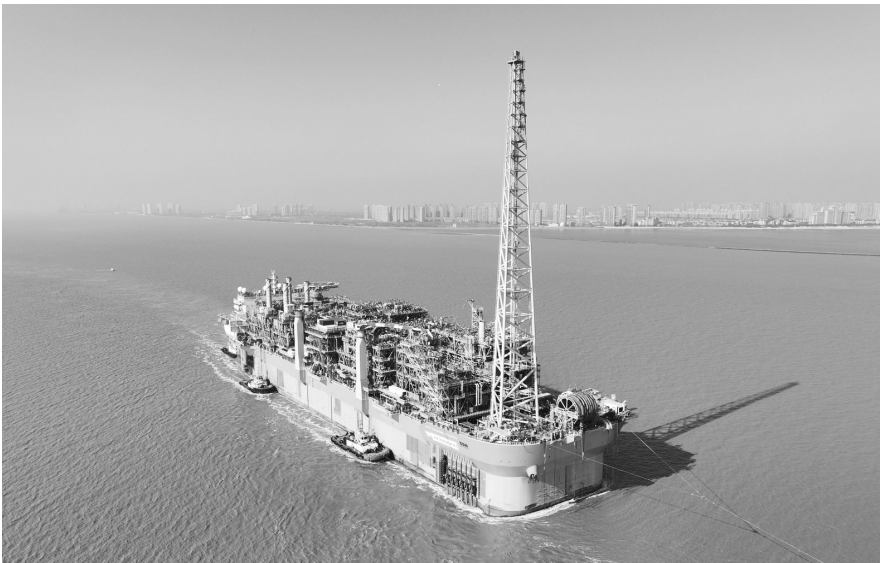
服务保障世界最大吨位、最大储油量新型“海上移动炼油厂”交付出江。南通海事局供图
