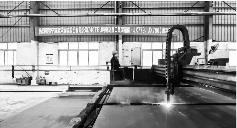
万吨级纯电动高端智能海船开工现场。 江西江新造船供图
