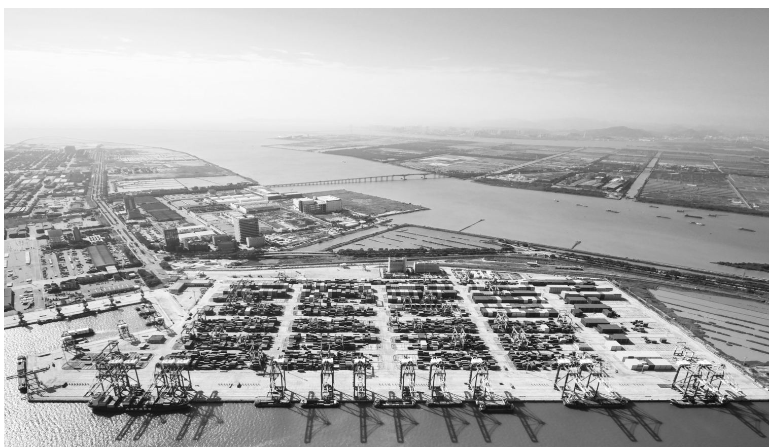
广州港南沙四期全自动化集装箱码头。 广州港供图
