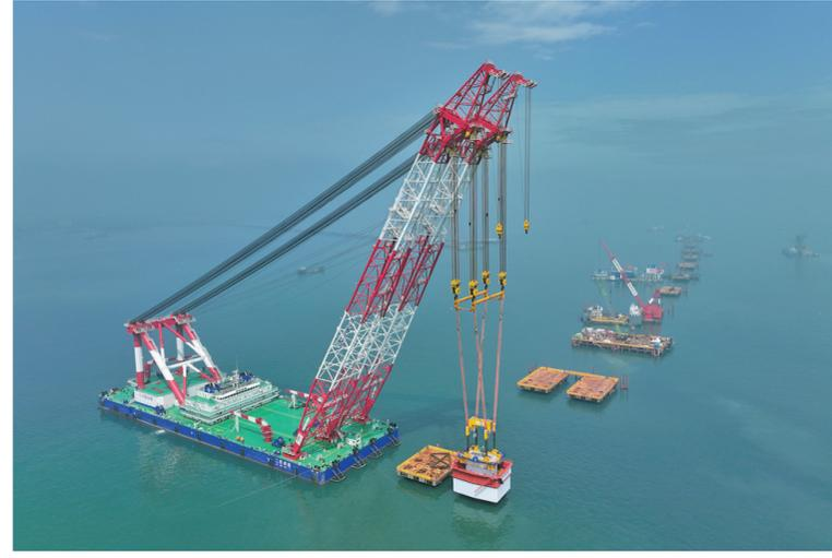
3月15日下午,厦金大桥(厦门段)项目首个预制墩台吊装作业圆满完成,重约3000吨的主线桥梁右幅35号预制墩台与海上桩基实现毫米级精准对接。标志着该项目海上主线桥梁进入装配化施工新阶段,开启项目建设“陆海协同、智能拼装”快速实施模式。
