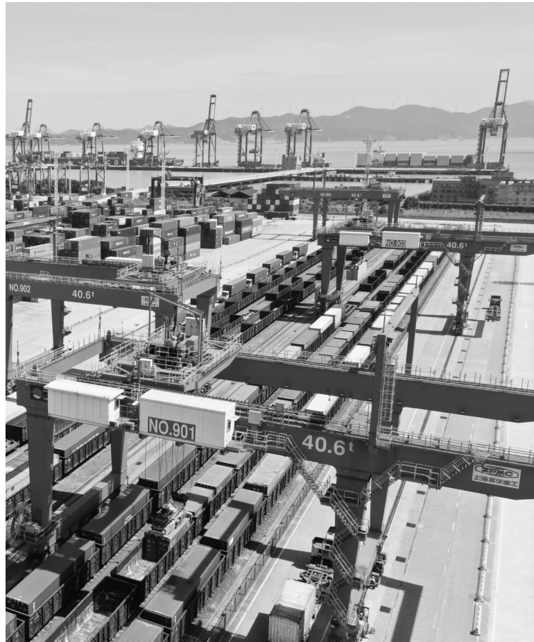
海铁联运作业现场。
