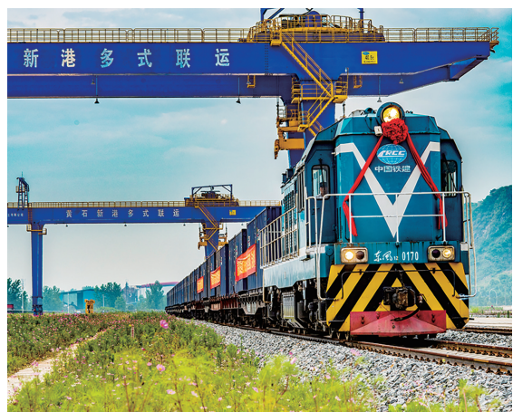
黄石新港多式联运铁路。
