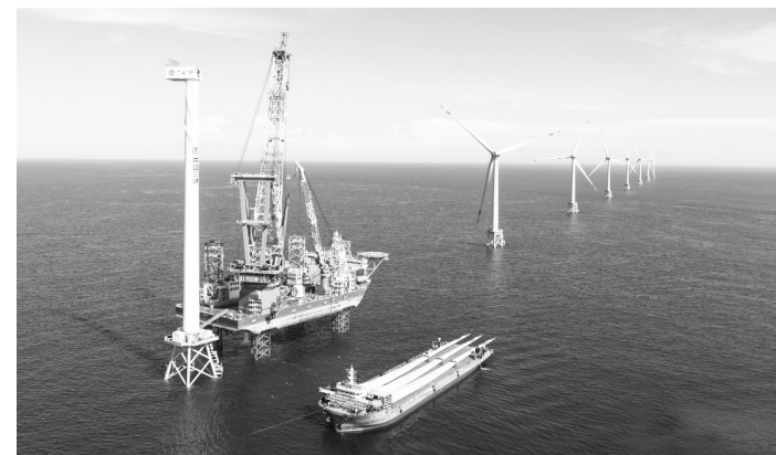
施工船安装海上风电叶片。本报资料室供图
