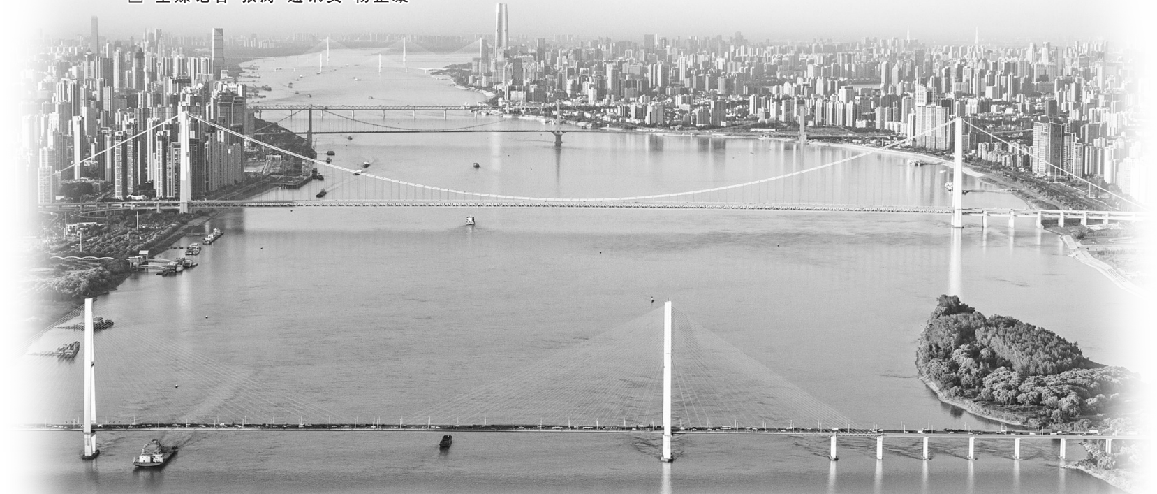
航拍武汉长江大桥群。本报资料室供图
